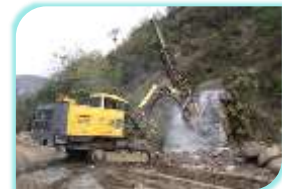
عملیات ساخت سد پلرود
