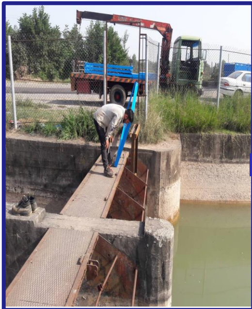
حمل دریچه های احدائی به محل پروژه
