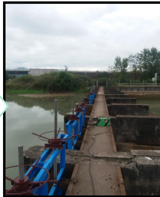
رنگ آمیزی فرمان دریچه ها
