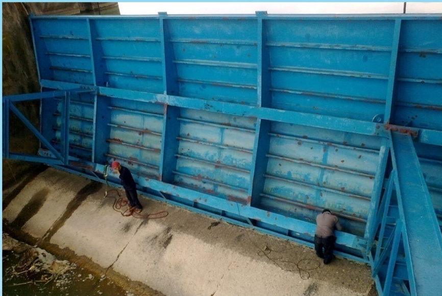
سند بلاست و رنگ آمیزی اپوکسی دریچه های سطحی
