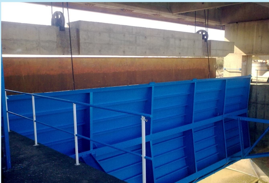
دریچه های سطحی بعد از عملیات سند بلاست و رنگ آمیزی
