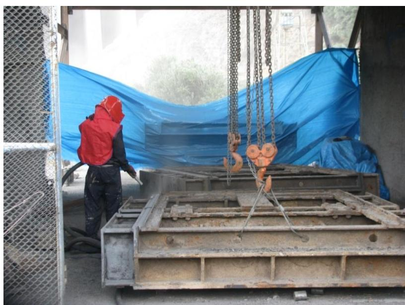
۲۶-۳-ترمیم خوردگی‌های روی لینکرادرها و پرداخت روی سطح آن
