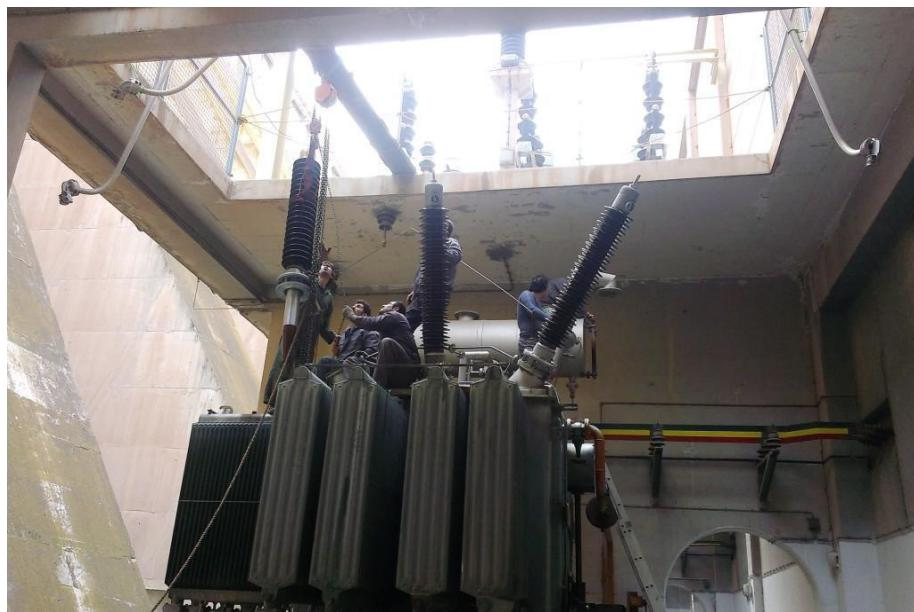
۳-۶- تزریق روغن به ترانسفورماتور و انجام عمل تصفیه فیزیکی با ایجاد خلا مصنوعی و افزایش دمای روغن توسط
