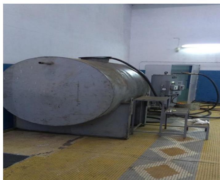
۱۴-۳-سرویس گاورنر و تخلیه رسوبات ته مخزن روغن
