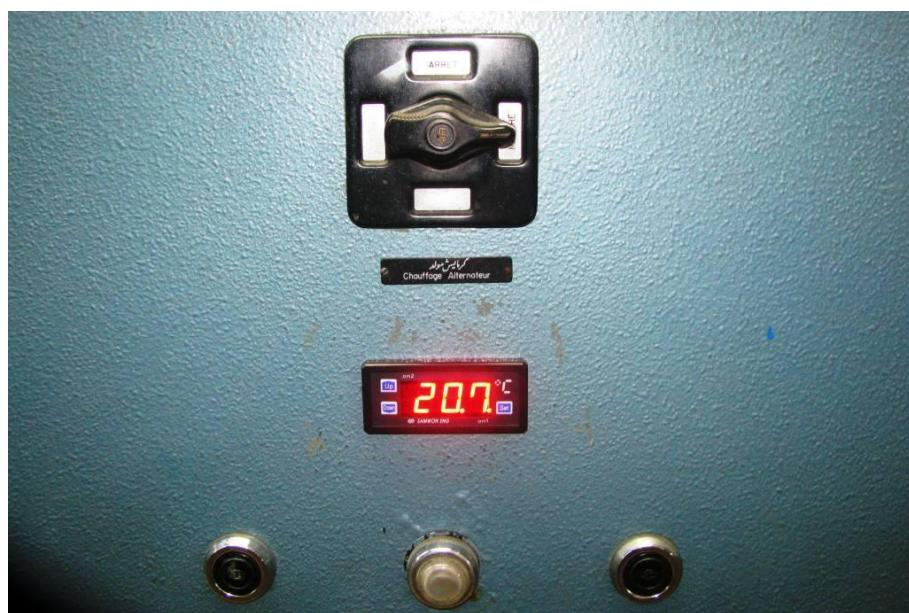
با تنظیم دمای مطلوب بر روی ترمومتر، کنترل‌کننده با قطع و وصل گرمکن‌ها دما را در حد مطلوب ثابت می‌کند.
