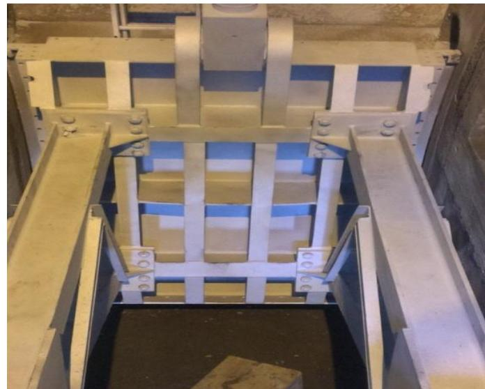
۷-۲۸-نصب واشرهای لاستیکی جدید و مونتاژ کامل دریچه قطاعی
