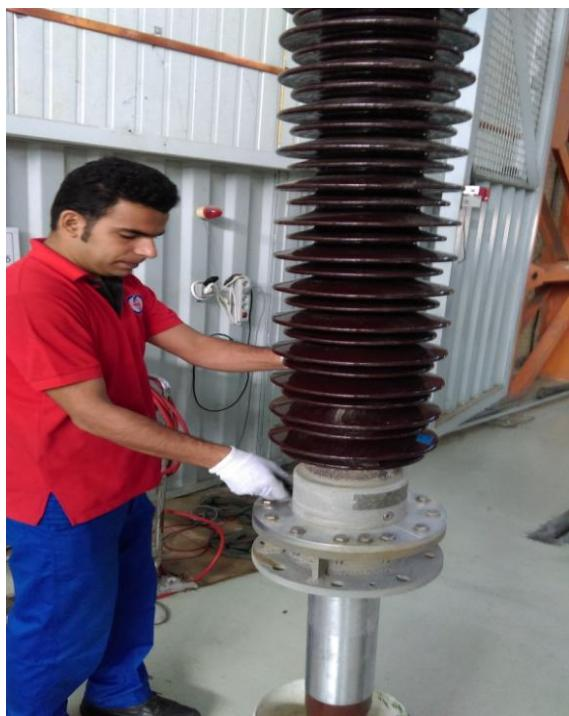
۲-۳- جدا کردن اتصالات، خارج ساختن بوشینگ‌ها و نصب درپوش برای جلوگیری از ورود آب‌گی و رطوبت به مخزن ترانسفورماتور.
