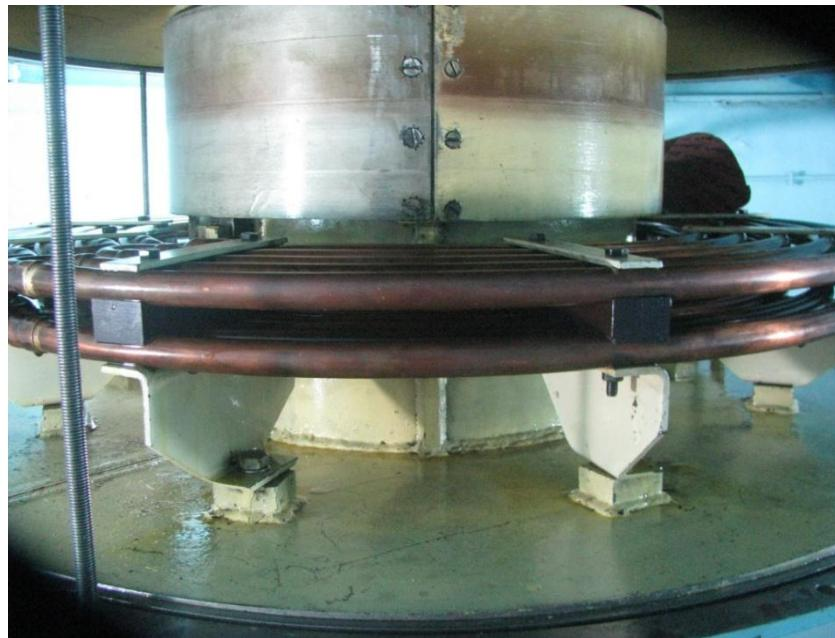
۱۳-۵-مونتاژ کارتر و اتصالات آب و روغن
