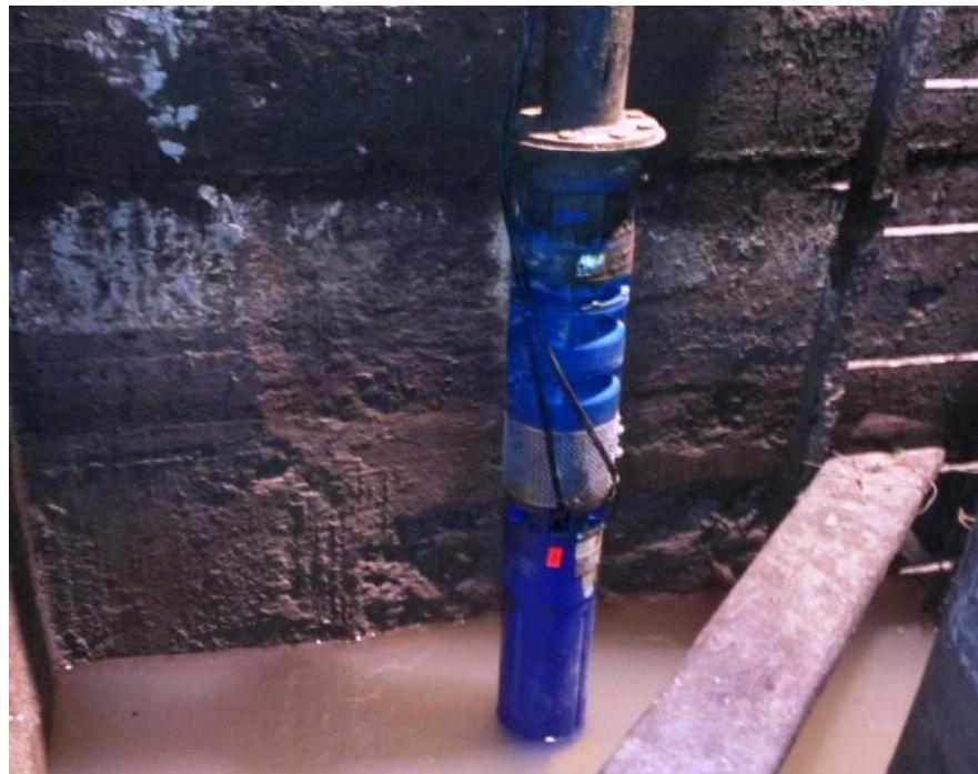
۲۱. دموناز سوپاپ پمپ ۱ شافت و غلاف نیروگاه و مونتاژ سوپاپ و توری جدید به همراه هواگیری
